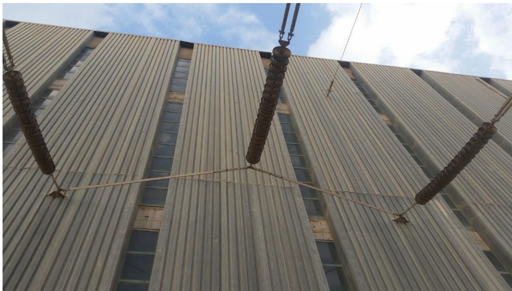
شکل (۱): زنجیره مقره چینی ۲۳۰ کیلوولت متصل به واحد ۳ نیروگاه رامین
