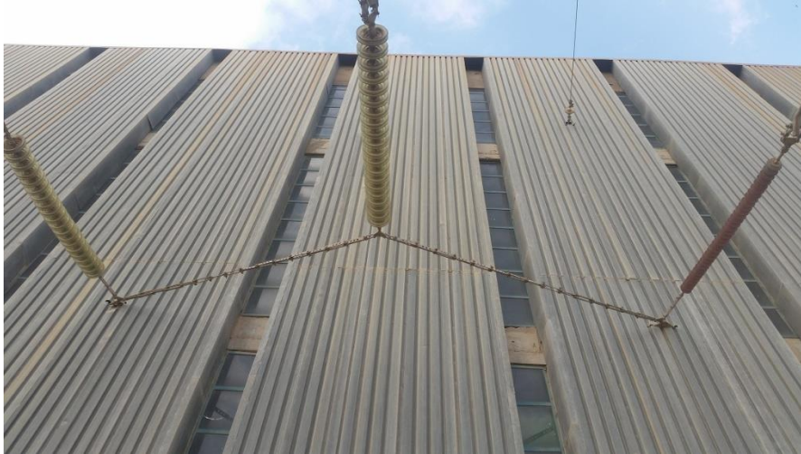
شکل (۲): زنجیره مقره چینی و سیلیکونی (سمت راست) ۲۳۰ کیلوولت متصل به واحد ۴ نیروگاه رامین
